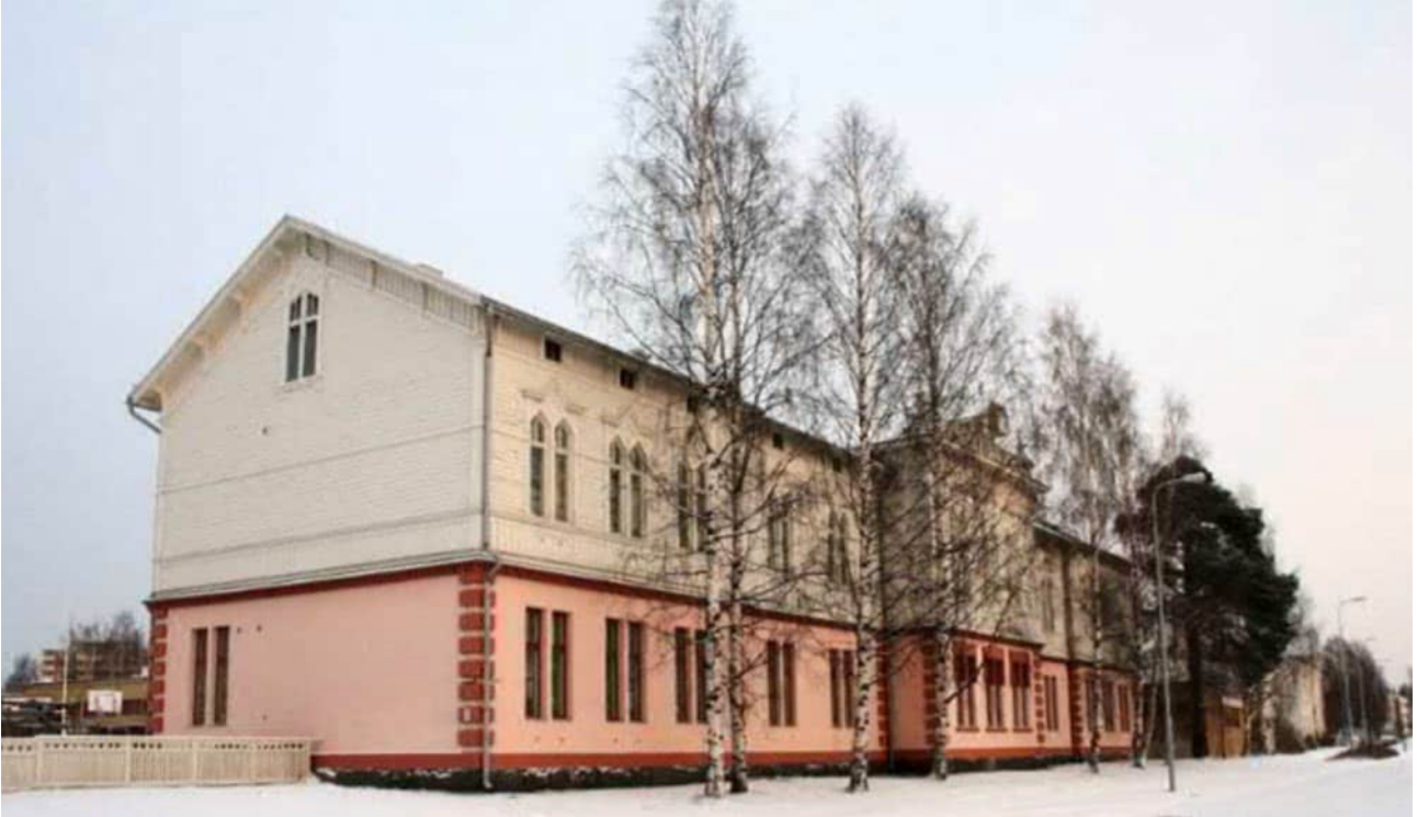
Kuva 3. Tuiran koulun vanhin osa vuodelta 1900. Ensimmäinen kerros on tiilirakenteinen ja toinen puurakenteinen.
